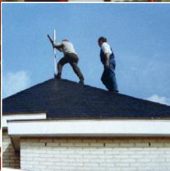
Plaatsing van het kruis.
