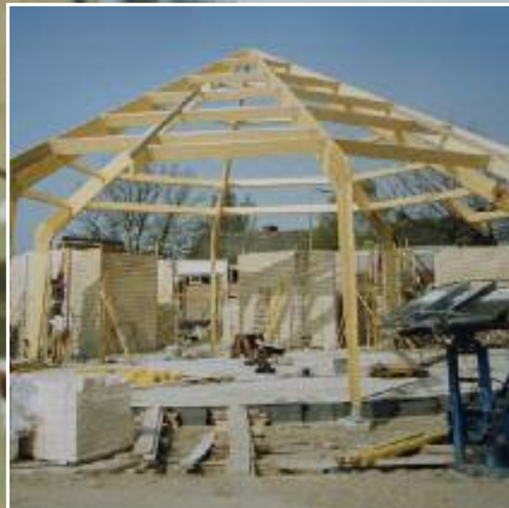
De bouw vordert gestaag.
